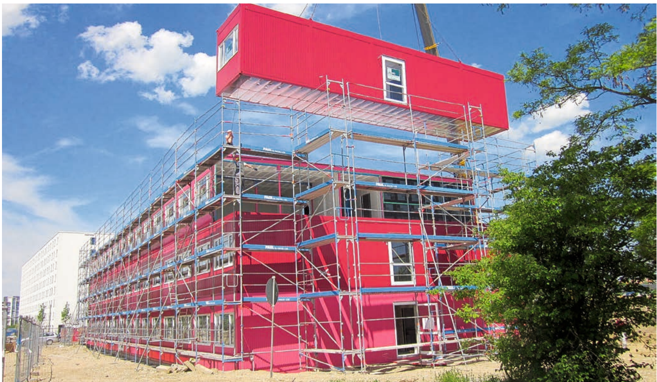
1 | Versetzen von Stahl-Raumzellen
