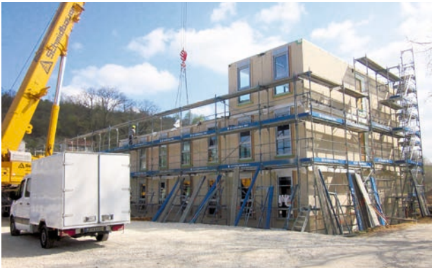
2 | Aufbau Stahl-Raumzellen
